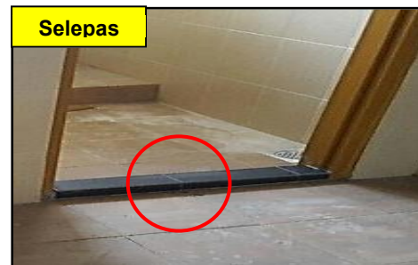
Dewan Komuniti Bandar Sunggala - Pembinaan Drop Telah Dibuat di Kawasan Lantai Tandas (24.1.2017)
