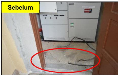
Sebelum Dewan Merdeka, MDR - Pelapik Getah Tidak Diletakkan di Atas Lantai di Hadapan Papan Suis (20.10.2016)
