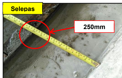
Dewan Komuniti Bandar Sunggala - Tread Anak Tangga Telah Dibaiki Mengikut Drawings (24.1.2017) (Sumber: Majlis Perbandaran Port Dickson)
