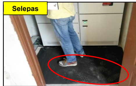
Selepas Dewan Merdeka, MDR - Pelapik Getah Telah Diletakkan di Atas Lantai di Hadapan Papan Suis (Sumber: Majlis Daerah Rembau)
