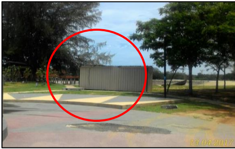
Pantai Cahaya Negeri - Kabin Tidak Dialihkan Keluar Dari Tapak Pembinaan (13.4.2017)
